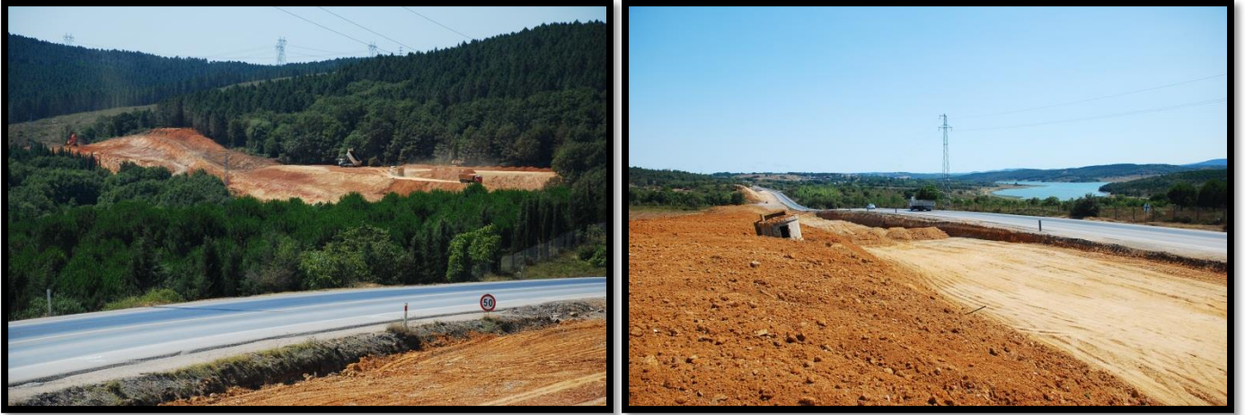
Şekil 20. Ömerli Havzası'nda (Baraj gölü çevresinde) 3. Köprü Projesi yol çalışmaları, 2011
